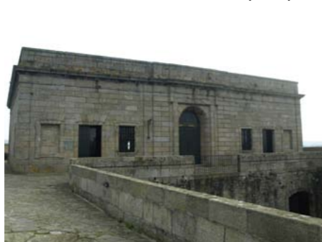
20. Casa del Gobernador. Fachada principal
