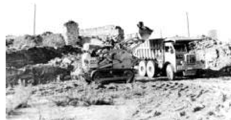
Castillo de San Diego, derribo. 1963. Foto Cancelo
