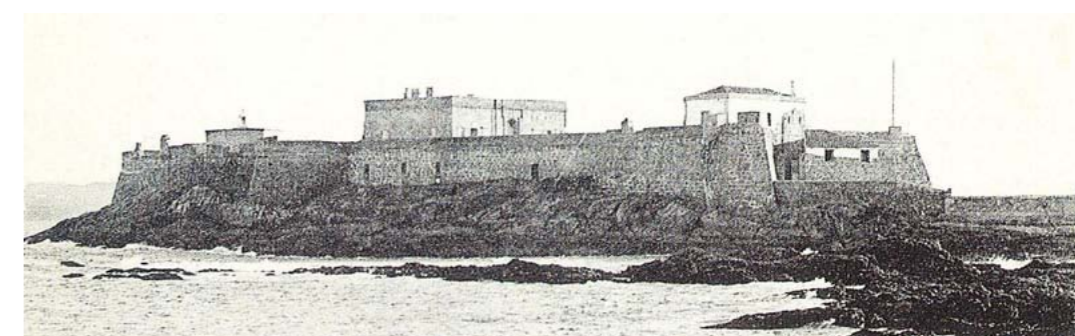
Imagen del Castillo anterior a la rehabilitación de Pons Sorolla donde podemos ver aún los cuarteles que serán demolidos y donde no existe aún la pasarela.
