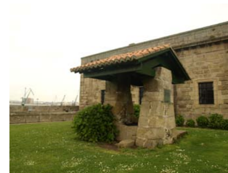
18. Pozo que aloja la linterna de la cisterna
