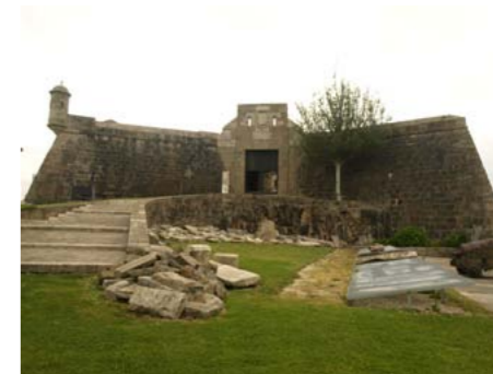
6. Tenaza entrada al recinto superior
