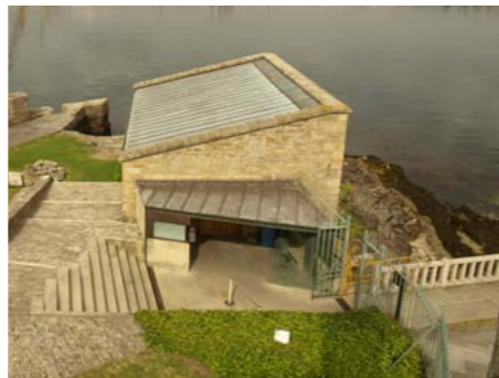
3. Casa del Botero rehabilitada
