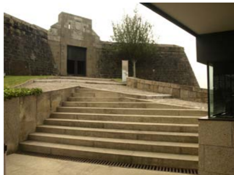
2. Nueva escalera de comunicación
