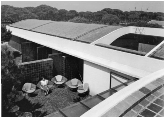
Figura 5.16. Alteración material: la trasera del patio en La Ricarda no adopta como acabado el revestimiento tectónico plano que caracteriza al resto de paramentos exteriores. [Fotografía de O. Maspons] Reproducido de “Rehabilitación de La Ricarda de Antonio Bonet”, por F. Álvarez y J. Roig, 2005, Tectónica , 18, p. 67.
