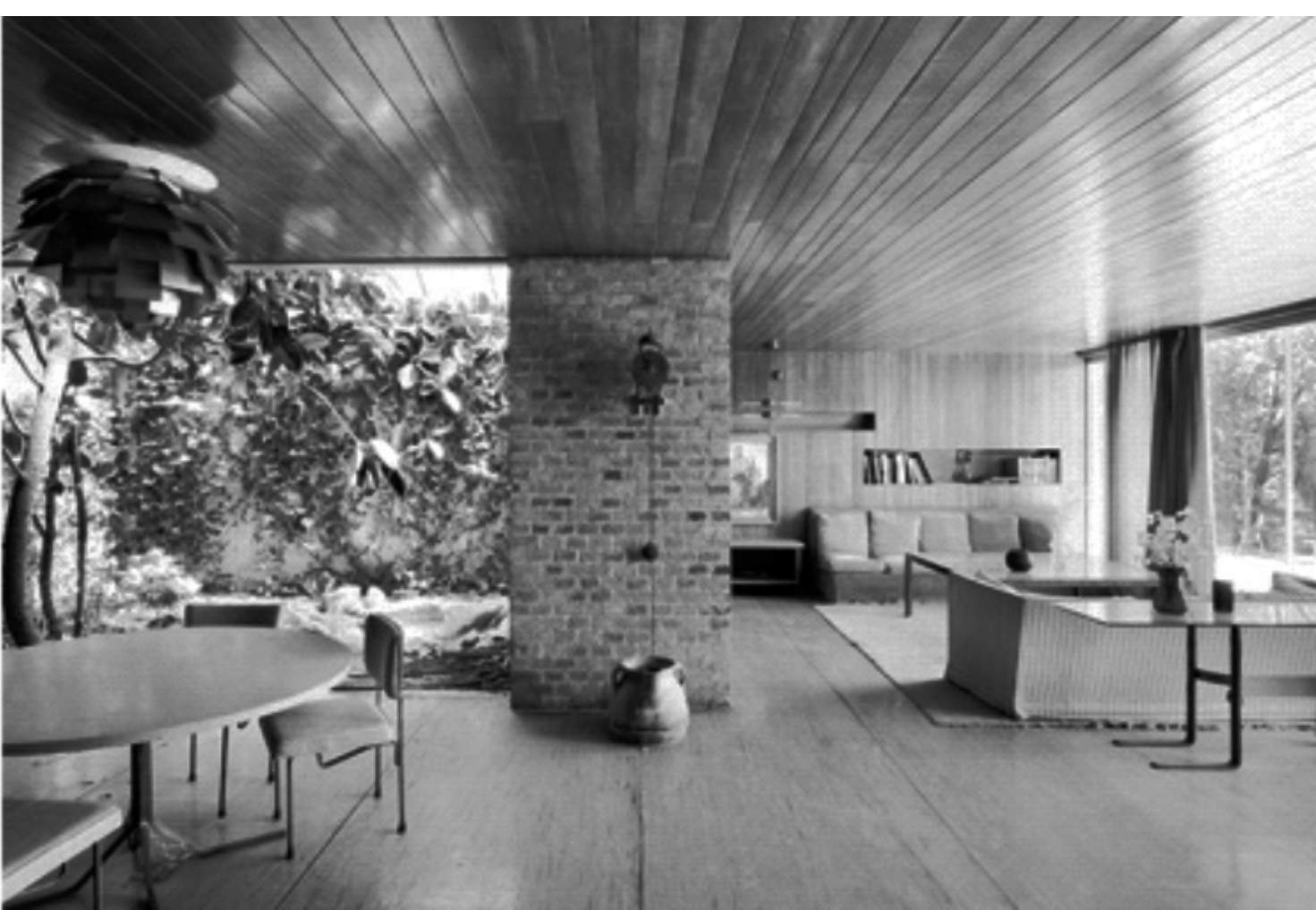
Figura 5.1. Reiteración material: tectónica plana . Revestimiento de listones de madera sobre techo y pared en la casa en Cerro del Aire. Reproducido de “Vivienda y estudio del arquitecto Miguel Fisac” por E. Hurtado Torán y S. Canosa Benítez, 2012, Archivo DOCOMOMO Ibérico . Recuperado de http://www.docomomoiberico.com/index.php?option=com_k2&view=item&id=413:vivienda-y-estudio-del-arquitecto-miguel-fisac&lang=pt
