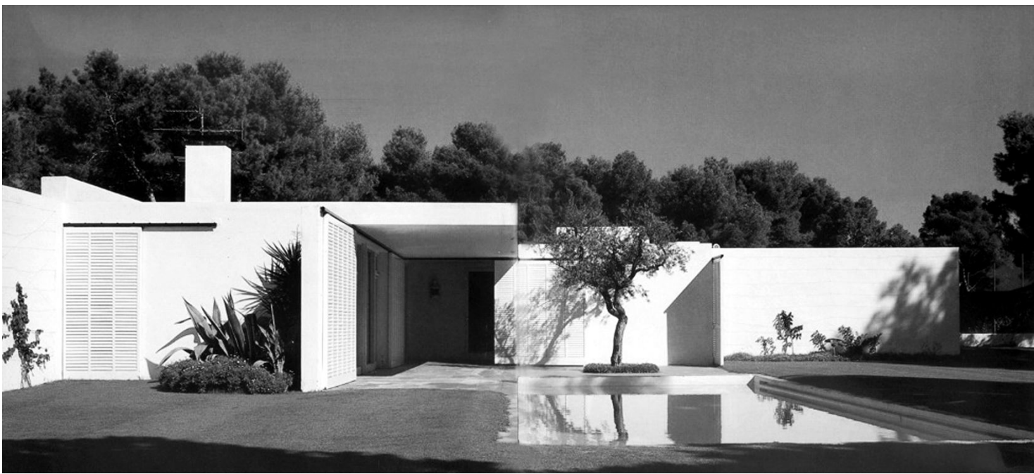
Figura 5.26. Ambigüedad sintáctica: intersección o deslizamiento espacial . En la casa Gili, la cubierta se extiende y forma un espacio intermedio, cubierto pero abierto, que además se desliza hacia el interior. [Fotografía de Duccio Malagamba, 1987]. Reproducido de “Casa Gili. 1965”, 1987, Arquitectura , 268, pp. 72-73. Copyright 1987 por Duccio Malagamba.
