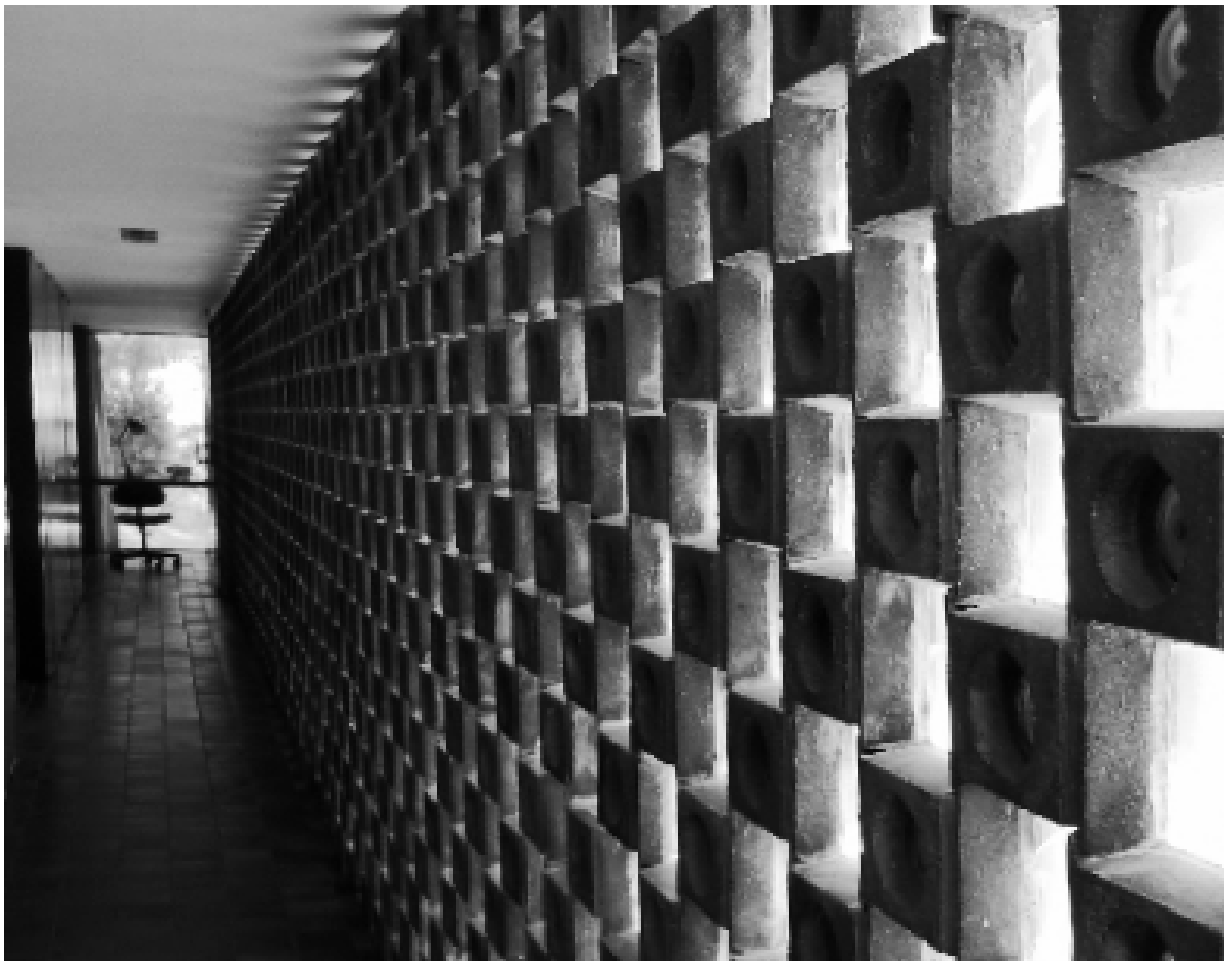
Figura 5.35. Contraste material: lo opaco y lo translúcido . Celosía del pasillo de los dormitorios en La Ricarda. [Fotografía de Emma Gomis]. Recuperada de http://notesfromtheinvisiblecore.blogspot.com.es/2011/09/when-john-cage-hung-out-with-my-family.html
