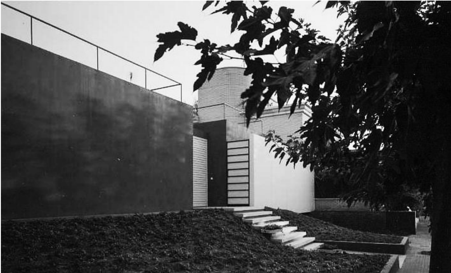
Figura 4.1.14. Hendidura que marca el acceso en la fachada principal. [Fotografía de Batlle i Roig]. Recuperado de http://merwanch.blogspot.com.es/2011/08/un-jardin-de-luces-en-la-casa-mmi.html . Copyright 2012 por Batlle i Roig.
